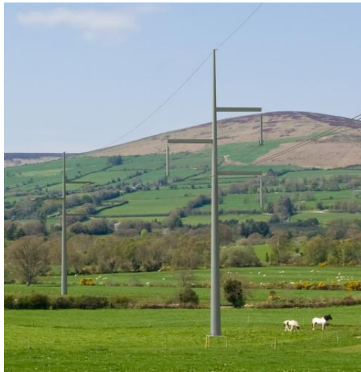
Fíor 4.16: Dearadh ‘Atkins’ don Túr Aeróige Aonpholaí agus an Túr Laitíse IVI a bheartaítear
