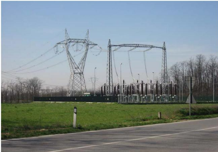
Fíor 4.11: Sampla de Stáisiún Aistrithe 400 kV ina n-aistrítear Cábla faoin Talamh go Líne Lasnairde
